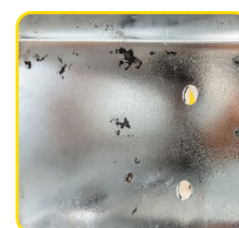
Lokální nedostatek galvanizace
